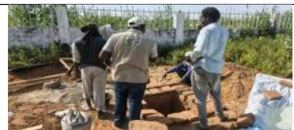
Image 5 : Construction des latrines du CTC de Chokoyane pour le déménagement de L'UTC du CDS urbain vers le L'hôpital de District de Chokoyane ; 06
