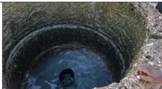
Image 3 : Supervision et traitements des puits dans les Ouaddi DS de Chokoyane, 30 Septembre 2025
