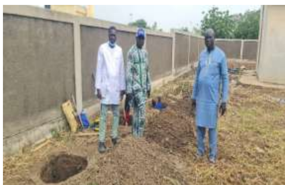
Image 7 : Réalisation des latrines par le CTC de Bitkine 21 Septembre 2025
