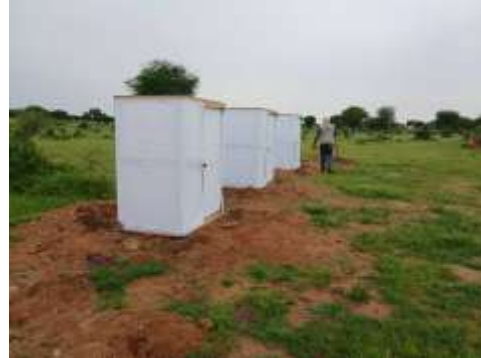
Image 4 : Construction des latrines par OXFAM au centre de santé de Goz Labane, Hadjer Hadjid 28 Aout 2025
