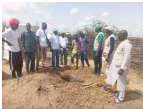
Image 2 : Supervision des activités de réalisation des nouvelles latrines à Dougui, 12 Aout 2025
